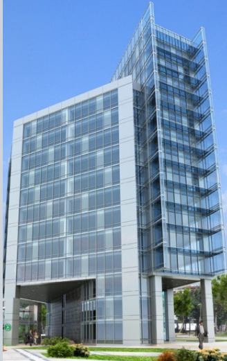
EDIFICIO CÓRDOVA – INMOBILIA Alonso de Cordova N° 5670, Las Condes N° de Pisos: 15 Sup. Util: 8.048 m 2 Planta Libre; piso tipo de 666,8 m 2 Fecha de entrega 4 to trimestre 2011
