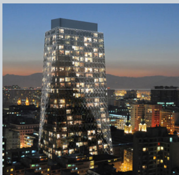
TORRE HUÉRFANOS Huérfanos N° 670 N° de Pisos: 27 Planta libre de 1.541 y 969 m 2 Fecha de Entrega: 4 to trimestre 2012
