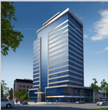
EDIFICIO EDICORP Av. 11 de septiembre 1151 Providencia N° de Pisos: 17 Entrega: año 2014
