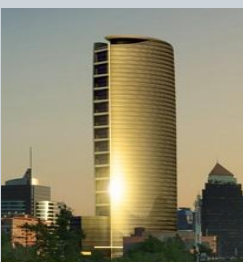
Torre Titanium – Las Condes . Certificación LEED Oro Fecha de Entrega: 1 er trimestre 2010
