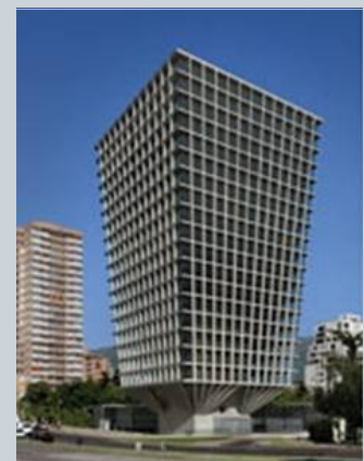
Edificio Apoquindo 4501 Las Condes Sup. Util: 7.840 m 2 Plantas de 700 a 1.350 m 2 Fecha de entrega 4to trimestre 2009
